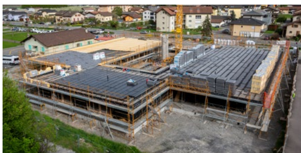
Les quatre futurs bâtiments se laissent deviner, et les premières baies vitrées ont été posées.
