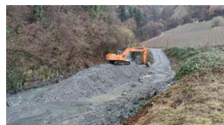
Remise en état de la Salentze, qui avait charrié de nombreuses alluvions fin 2023.
